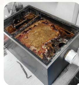
Čistenie lapača tukov a potrubí
